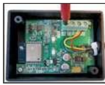
10.23 Koppla loss kablarna.
